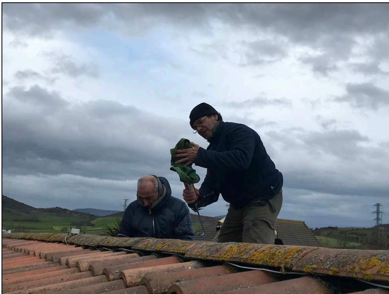
Pedro Martorell y el dueño de la Casa Rural Cuidando Te, en Mutilva Baja, finalizando la instalación del fotómetro stars 302/PLN 02 en el tejado de la vivienda.
