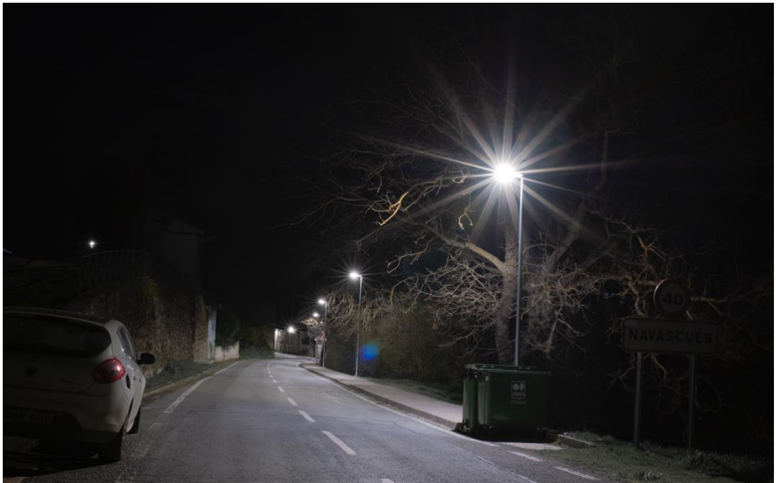
Figura 19. Entrada a la localidad de Navascués por el puerto de las Coronas. En lugares donde la conservación de hábitats y especies tiene una importancia especial, hay que plantear la renovación del alumbrado con criterios diferentes a los de las grandes ciudades. Los LED Blancos que están sustituyendo a las tradicionales lámparas de VSAP pueden tener un efecto pernicioso en el medio ambiente, aumentando el estrés al que someten a muchas especies.
